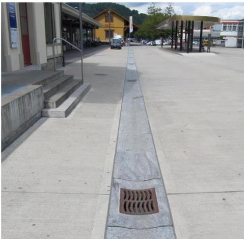
Abb. 35: Referenzbild: Granitsteinschale in Betonbelag eingelassen
