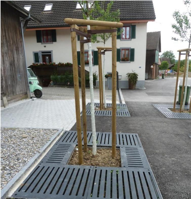
Abb. 32: Referenzbild: unterirdische Baumgrube und Abdeckung aus Gussrost
