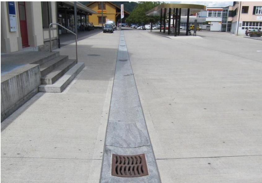
**Abb. 23:** Referenzbild: Granitsteinschale in Betonbelag eingelassen
