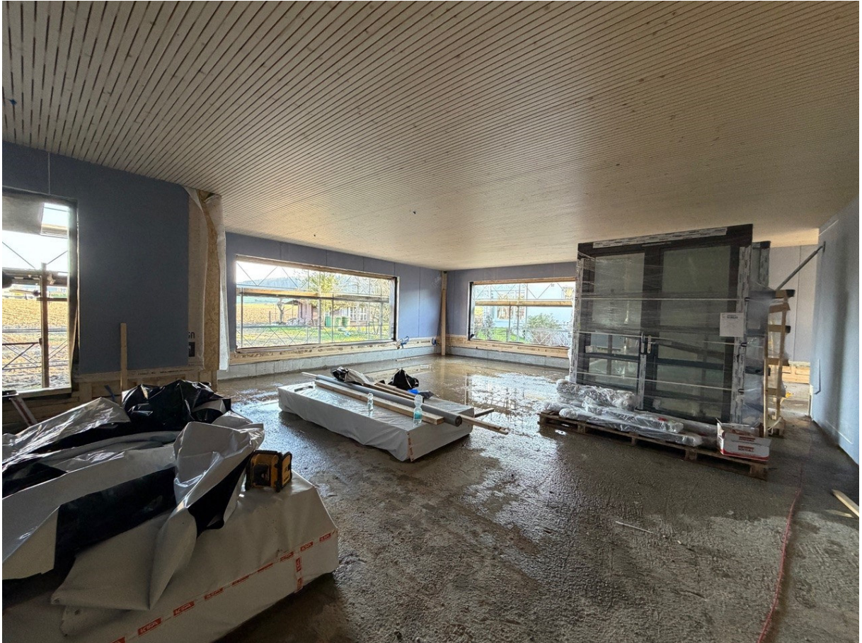
Innenansicht des neuen Doppelkindergarten Farn
