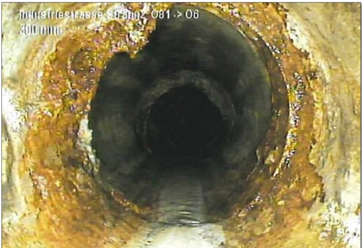
Abb. 6 Muffe verkalkt, stark
