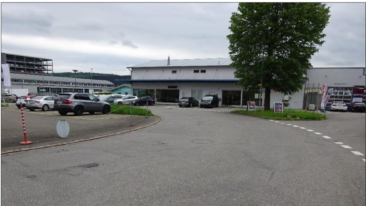
Abb. 10 Strassenzustand bei Kurve vor ehem. Fa. Käppeli
