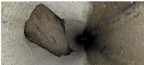
Durchdringung Trinkwasserleitung durch Kanalisation
