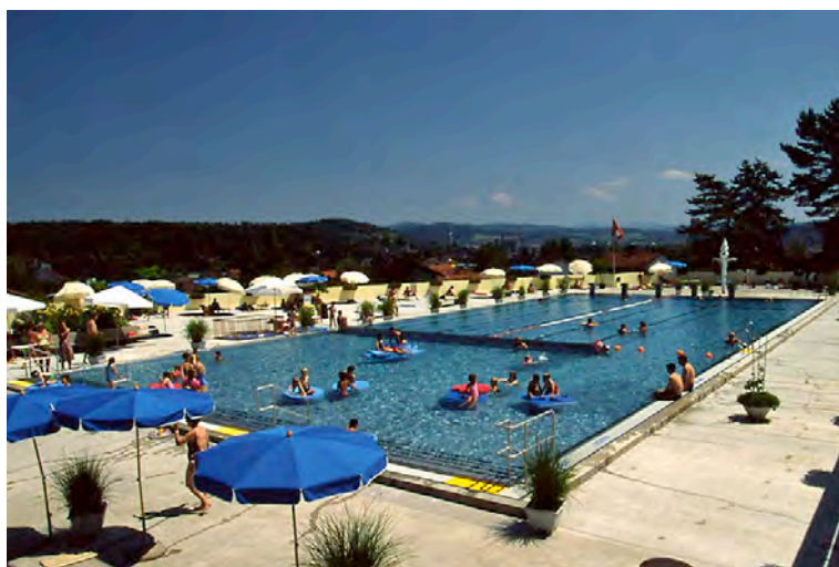
Abb. 10: Beispiel Schwimmbecken Wolfensberg, Winterthur, mit Überlauf und Beckenauskleidung aus Chromstahlblech
