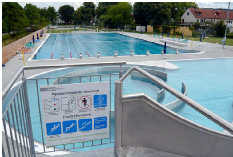
Abb. 11: Beispiel Freibad Geiselweid, Winterthur, mit Chromstahlblechhauskleidung und mit Geländer und Rutsche in nicht rostendem Stahl
