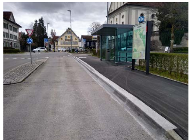
Bushaltestelle Kirchenplatz, ausgebaut nach Vorgaben Behindertengleichstellungsgesetz
