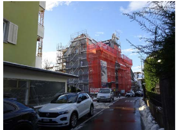
Umbau Wohn- und Gewerbehaus, Chilegässli
