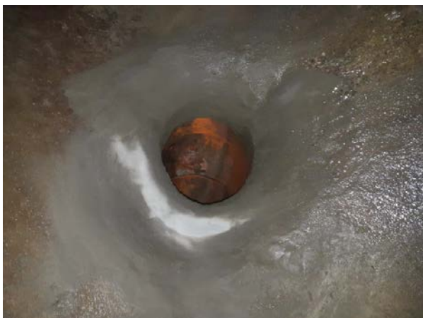
Anschluss nach der manuellen Sanierung
