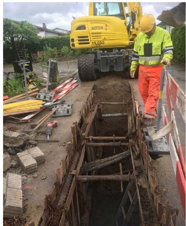
Gepriesster Werkleitungsgraben für Leitungsersatz Kanalisation
