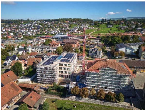
Neubau Primar Halde und Gesamtsanierung Altbau Primar
