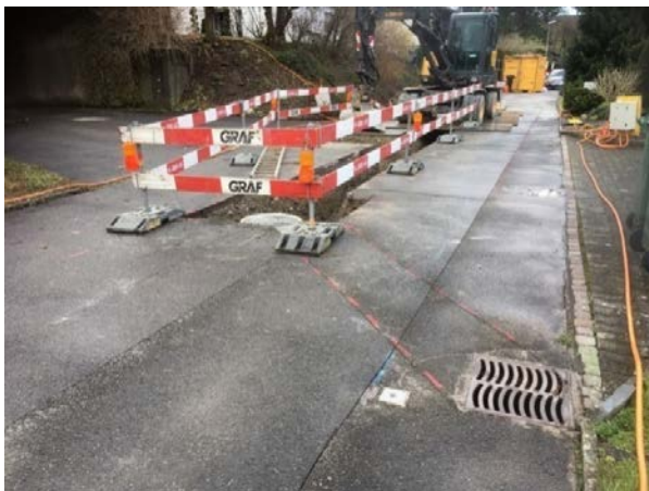
Grab- und Rohlegearbeiten für die Änderung der Strassenentwässerung
