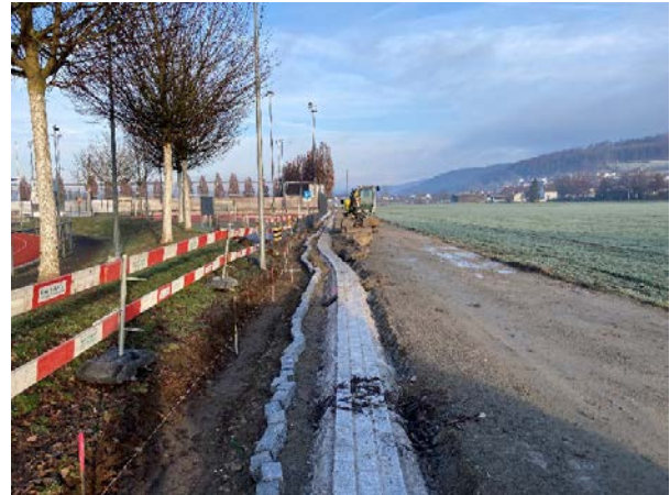
Sorenbühlweg - Umsetzung der 3. Etappe
