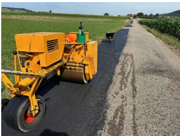
Sanierung Ränder in der Sandackerstrasse
