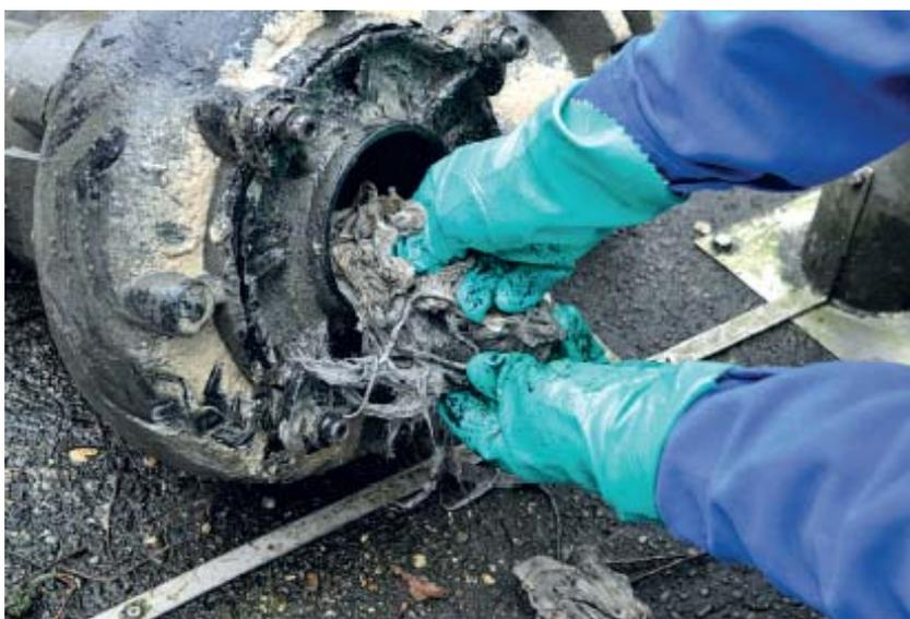
Foto: Feuchttücher und andere Hygieneartikel sind Pumpenkiller. Sie bilden zähe Faserknäuel, die in mühseliger Handarbeit entfernt werden müssen.
