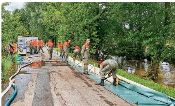
Aufbau Hochwasserschutz in der «ARA im Blettler»
