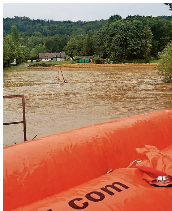
Hochwassersperrungen mit dem «Beaver Schlauchdamm» zum Schutz der «ARA im Blettler»
