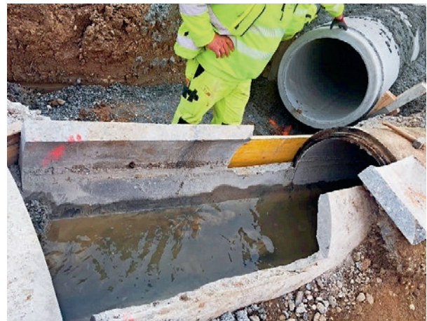
Zusammenschluss neue Abwasserleitung an bestehende Schmutzwasserleitung im Bereich Nutzenbachstrasse
