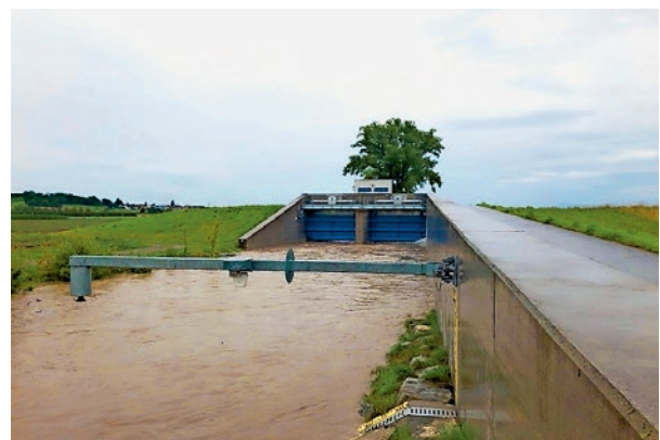
Hochwasserrückhaltebecken mit einem sehr hohen Wasserstand
