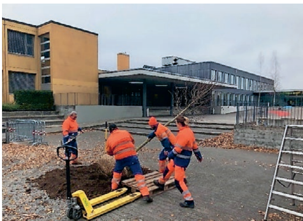
Vorbereitungsarbeiten durch den Werkhof beim Schulhaus Junkholz
