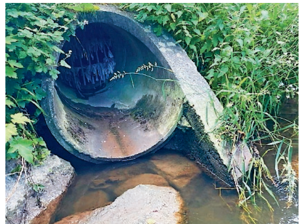
Feststoffe bleiben am Gitter bei Einleitstelle in die Bünz hängen
