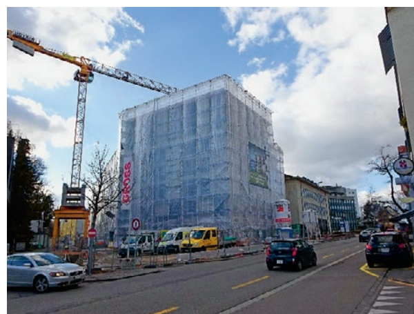
Baustelle Zentralstrasse / Bahnhofweg
