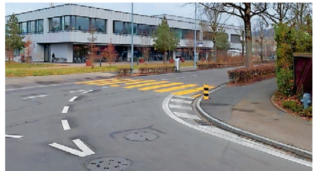
Erstellung einer Fussgängerquerung vor der Integra, Stiftung für Behinderte im Freiamt, Allmendstrasse
