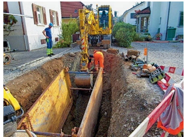
Einbau Grabenspriessung für neue Kanalisationsleitung im Klaraweg
