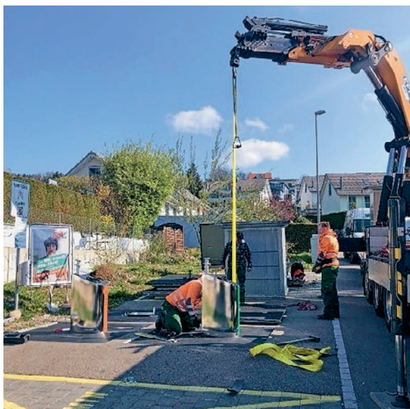
Umbau Sammelstelle Anglikon
