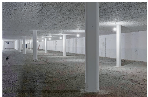
P+R-Anlage kurz vor der Inbetriebnahme
