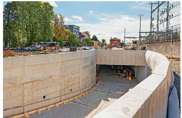
Einfahrt zur neuen P+R-Anlage
