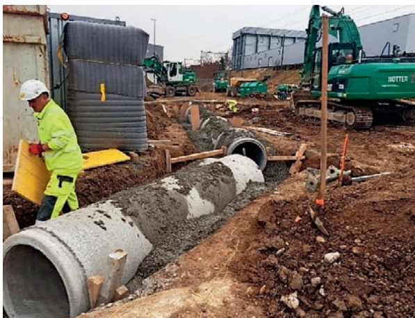
Einbau Abwasserleitung im Bereich Nutzenbachstrasse
