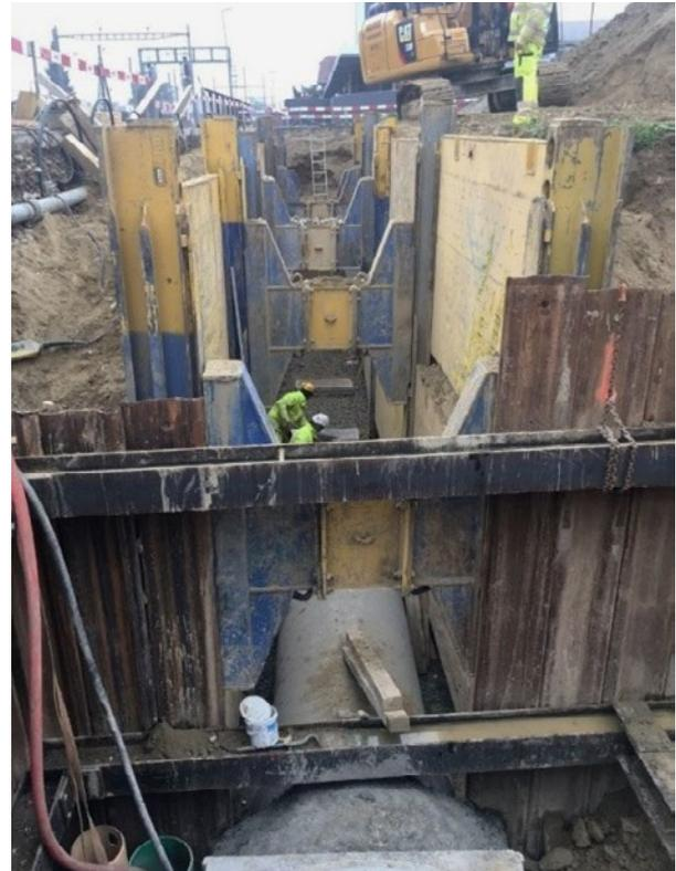
Baugrube für den Einbau der neuen Abwasserleitung
