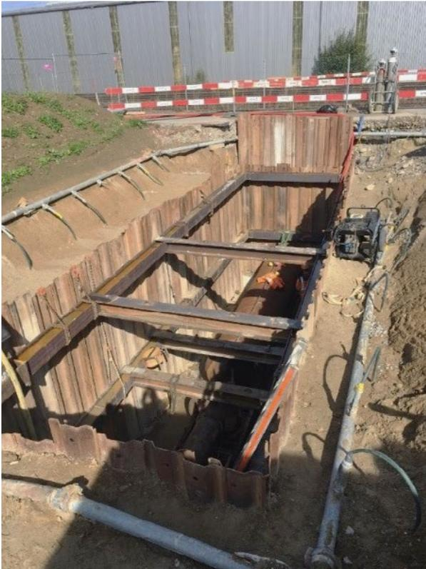
Startgrube für Stahlrohr-Rammung unter SBB-Damm
