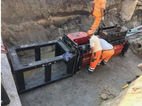
Ersatz Abwasserleitung mittels Berstlining-Verfahren/Zielgrube mit Berstmaschine
