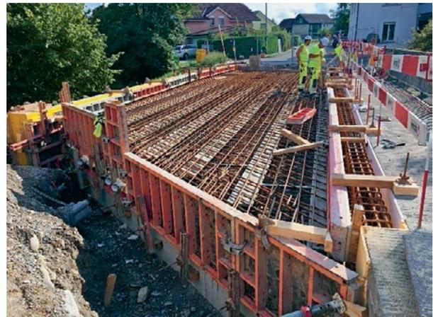
Bewehrung für neue Brückenplatte fertig verlegt
