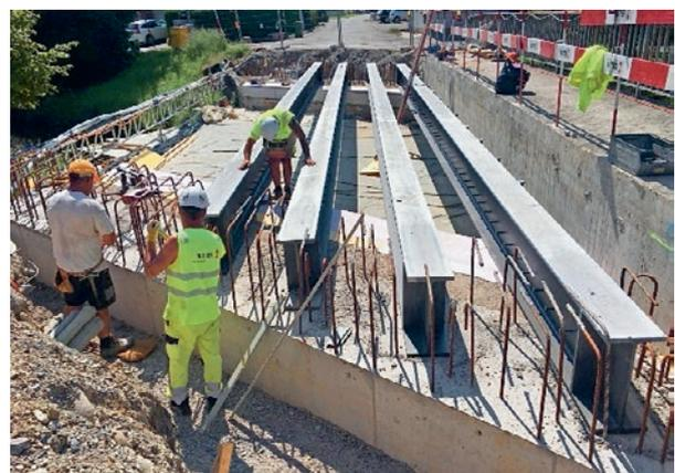
Stahlträger für Brückenplatte werden eingebaut
