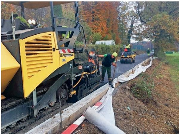
Einbau Asphaltbelag mit Einbaumaschine
