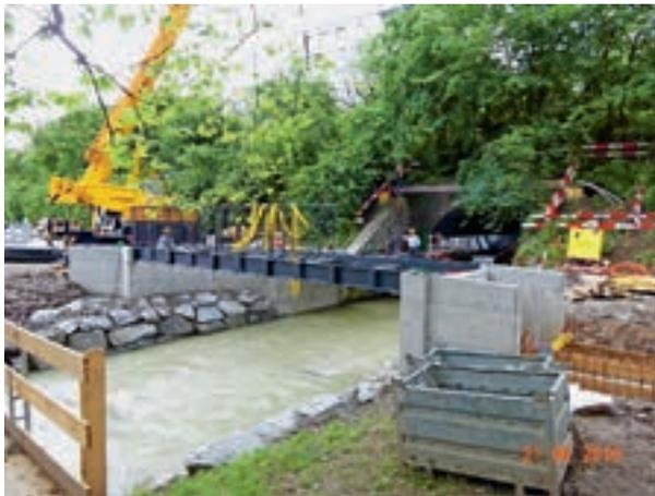
Einkarnung der neuen Stahlbrückenkonstruktion Junkholz
