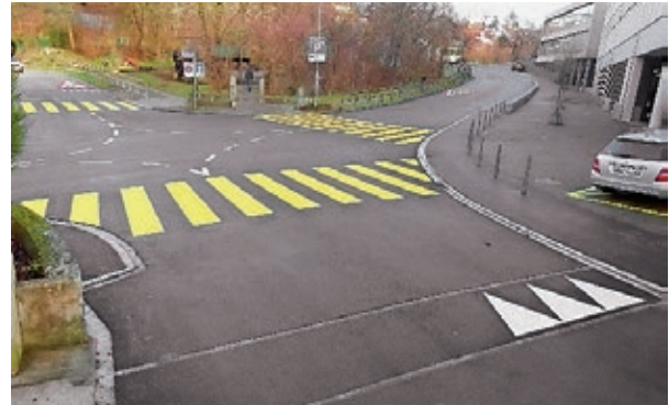
Knoten Talbisgässchen/Steingasse/Hofmattenweg nach der Sanierung
