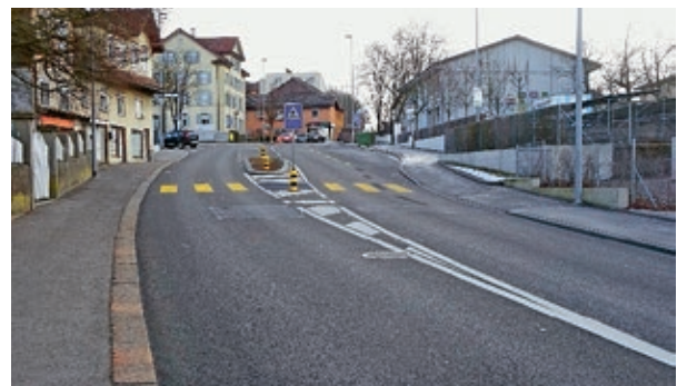
Sanierte Fussgängerquerung «Chäber» auf der Bremgartnerstrasse
