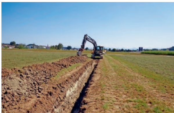
Grabenaushub für neue Drainage
