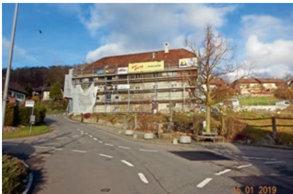
Baustelle Um-/Anbau Ratsherrenhaus Anglikon
