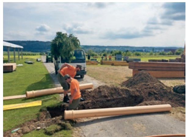
Bau Wasserleitungen Kreisturnfest Dintikon
