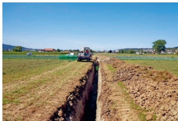
Verlegen der Leitung
