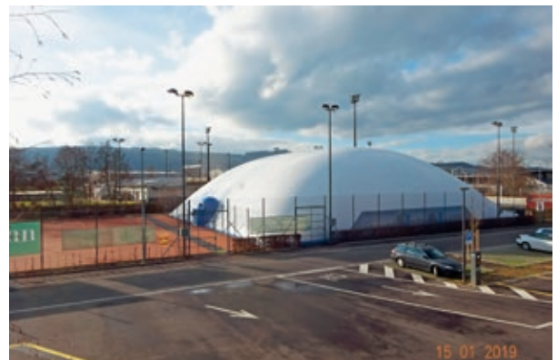
Neu erstellte Energietraglufthalle des Tennis Clubs Wohlle
