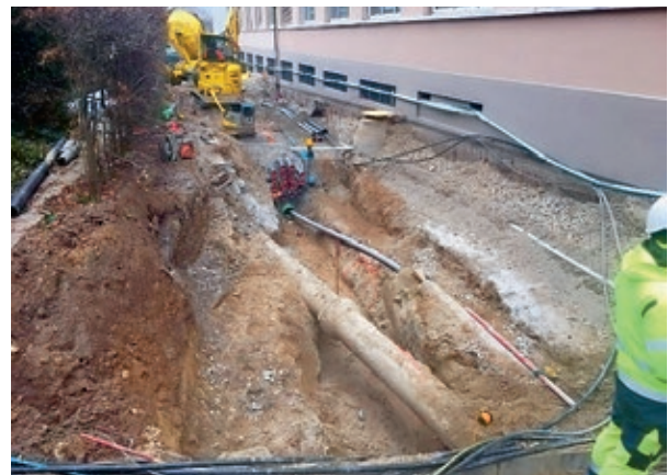
Werkleitungsgaben im Schulweg
