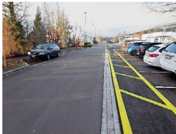
Der sanierte Sorenbühlweg im Bereich vor der neuen Eishalle
