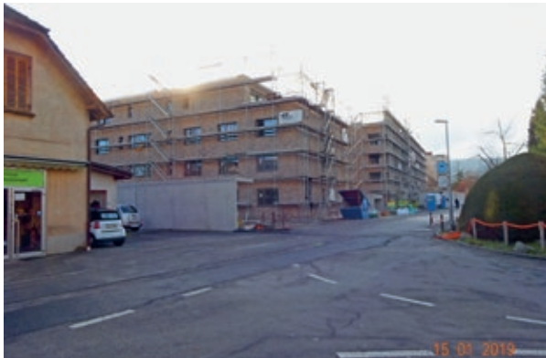
Baustelle Überbauung Alte Villmergerstrasse
