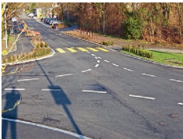
Allmendstrasse nach der Sanierung
