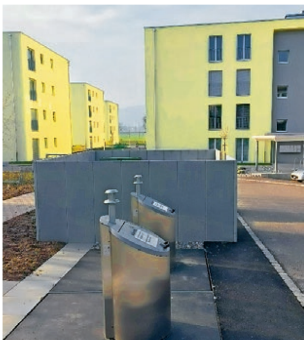
Unterflur-Kehrichtsammelstelle bei der Überbauung Wohlermatte
