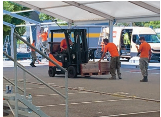
Aufbau Infrastruktur am Eidgenössischen Pontonierwettfahren
