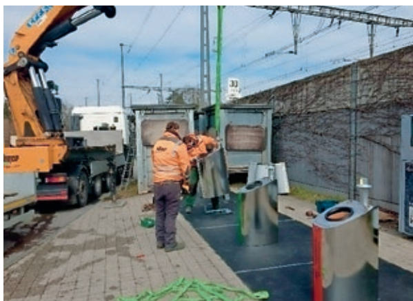
Die Sammelstelle während des Umbaus
