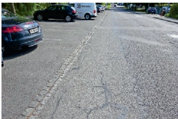
Allmendstrasse vor der Sanierung
