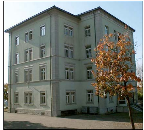
Primarschulhaus Halde, Hauptgebäude
