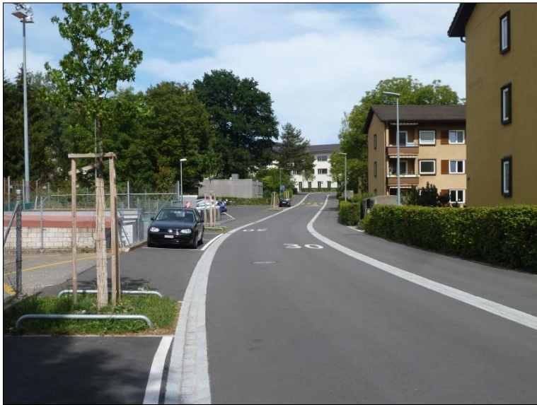
Beispielbild Dreireihiges Natursteinband als beidseitiger Fahrbahnabschluss
