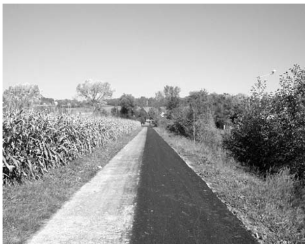
Sanierung Flurweg Mattenhofweg - Sorenbühlweg
