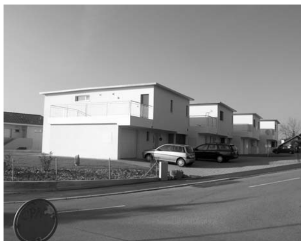
4 Reiheneinfamilienhäuser Albisweg, bzw. Rummelstrasse
