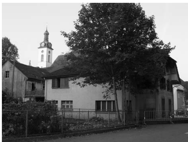
Steingasse 2 (durch Brand)
