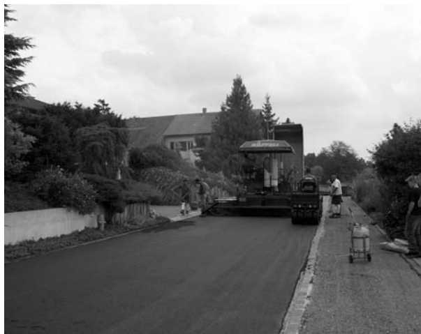
Deckbelag Gyrenhübelstrasse
