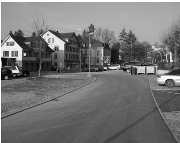
Bünzstrasse bis Trafostation
