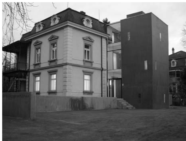
Anbau reformiertes Kirchgemeindehaus
