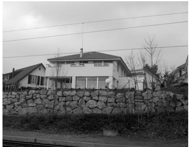
Einfamilienhaus untere Haldenstrasse
