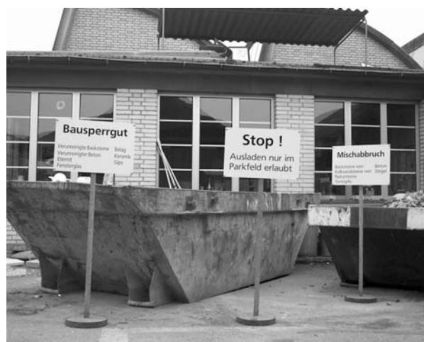
Neue Beschriftung in der Entsorgungsstelle Bauamt
