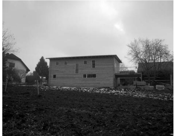
Einfamilienhaus am Oberdorfweg
