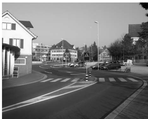
Aufweitung Bünzstrasse mit Fussgängerstreifen
